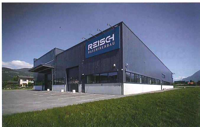
Platz für neue Projekte: In der neuen Montage- und Lagerhalle werden vorwiegend Sonderanlagen und Maschinen fertiggestellt.
